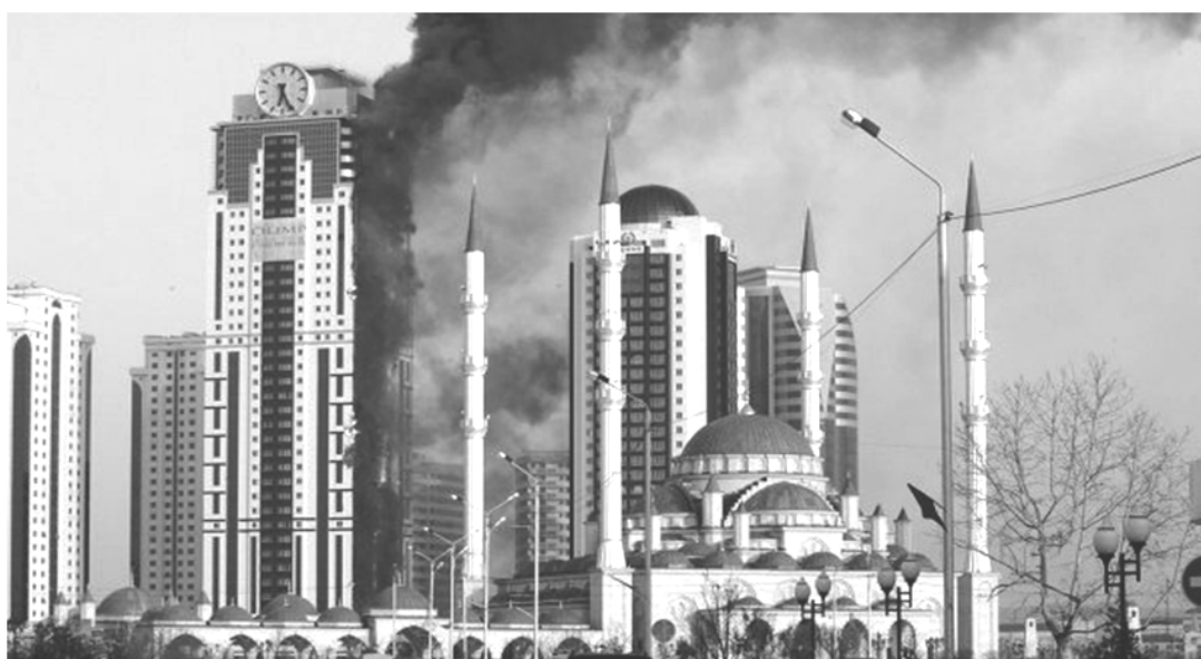
Рис. 4. Возгорание зданий, утепленных некачественным утеплителем, Грозный, 2013
