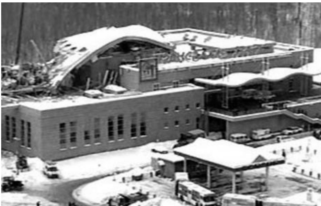
Рис. 3. Разрушенная кровля Трансвааль- парка, Москва, 2004.
